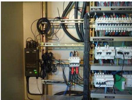
Vue du PEL102 à l'intérieur du TGBT
