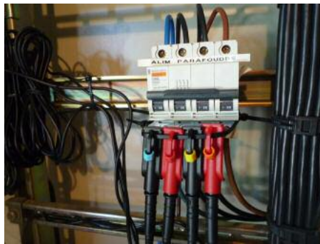
Prise des tensions en aval du disjoncteur parafoudre
