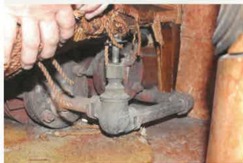
Tubes à ailettes en fonte sous la banquette (avant le démontage)
