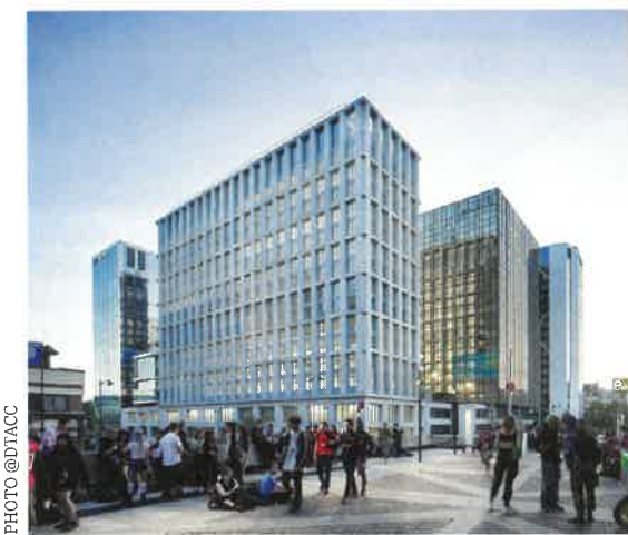
Les bâtiments à usage tertiaire doivent faire l'objet d'un contrôle des systèmes de ventilation conformément au «protocole de contrôle des systèmes de ventilation des bâtiments non résidentiels».
