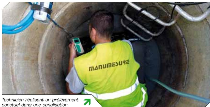
➔ Technicien réalisant un prélèvement ponctuel dans une canalisation.
