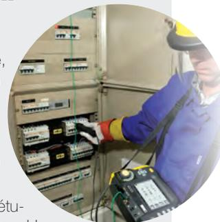
Dans le domestique, le tertiaire ou l'industrie, les contrôleurs d'installation multifonction permettent de vérifier la conformité d'une installation électrique selon les normes en vigueur. Cette vérification est obligatoire pour obtenir l'assurance d'une installation ne présentant aucun danger.
