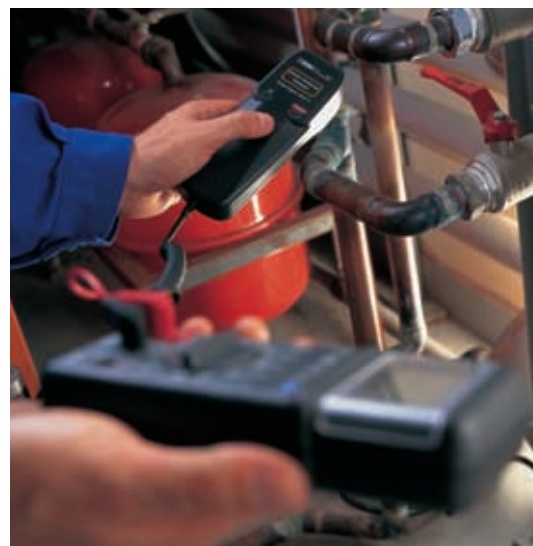
Mesure de température sans contact avec la sonde infrarouge C.A 874
