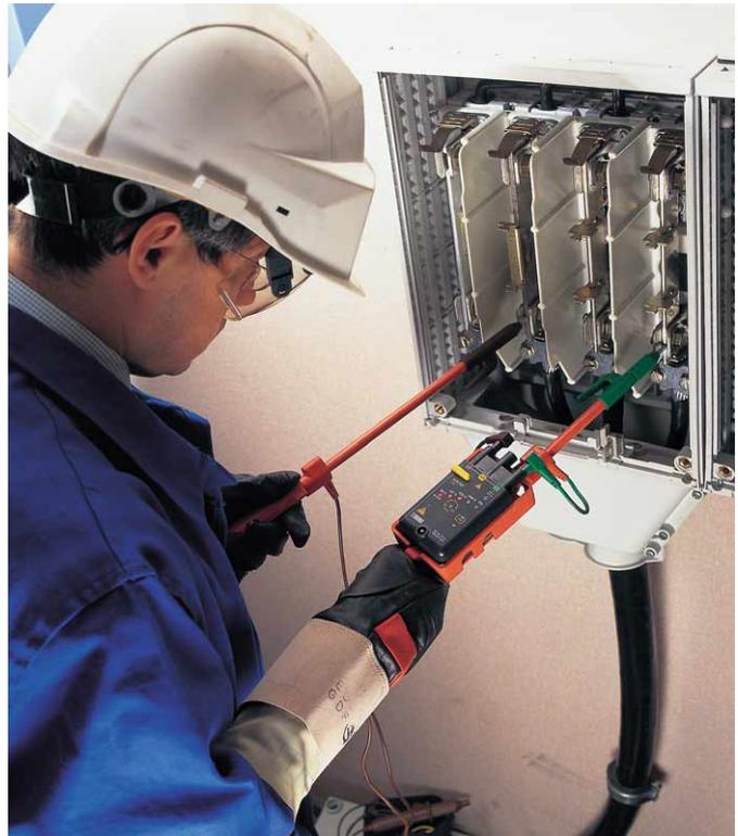
Détection de tension à distance, dans un coffret HPC basse tension à l'aide de perches isolantes.
